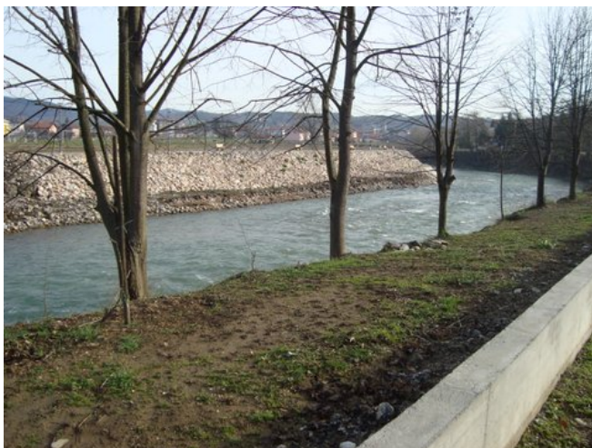
Слика 38. Уређена (обложена) коса обала ријеке Врбање - Челинац
