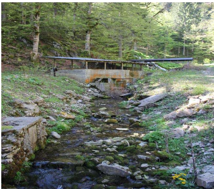
Слика 23. Извориште ријеке Врбање – Загат и почетак тлачног цјевовода МХЕ
