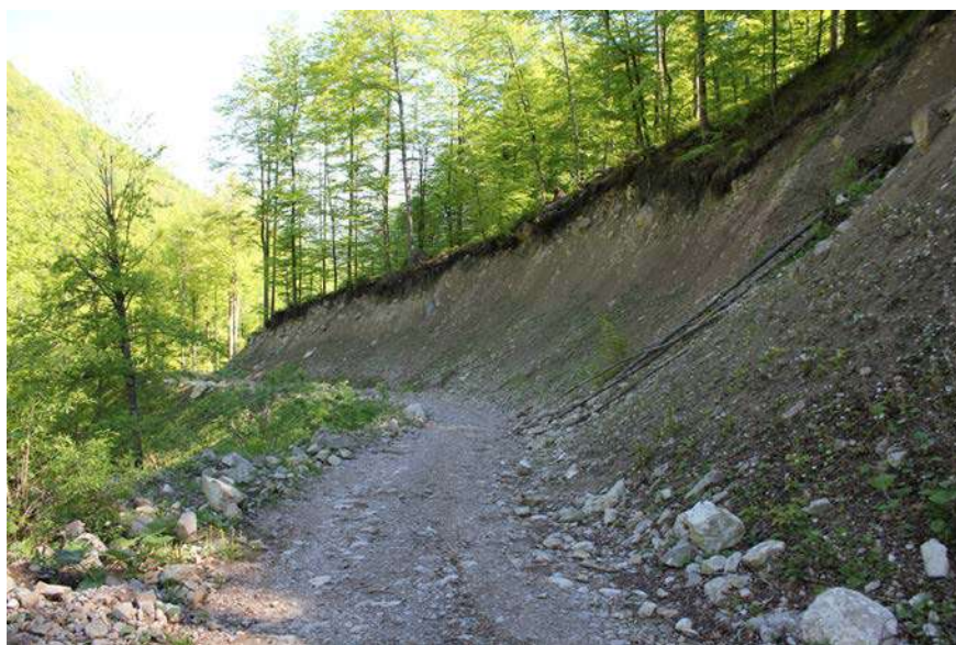
Слика 27. Изградњом путева за потребе МХЕ активирају се бројна потенцијална клизишта 568
