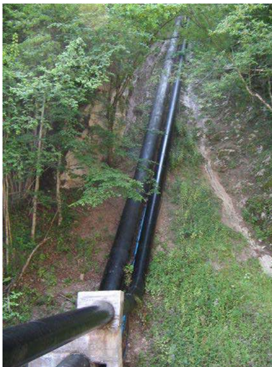
Слика 26. Дио тлачног цјевовода у близини машинске хале МХЕ
