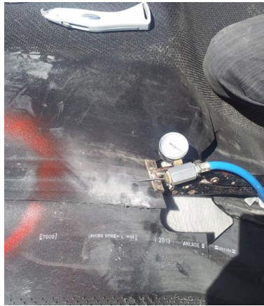
Slika 10.20. Zavarivanje i ispitivanje sintetičke membrane (folije) na deponiji Ramići, Banjaluka (EKO-EURO TIM, 2014)
