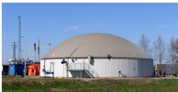
Slika 8.18. Elektrana na biogas u Zrenjaninu, „Bioelektra”, kapaciteta 600 kW (Grad Zrenjanin, 2020)
