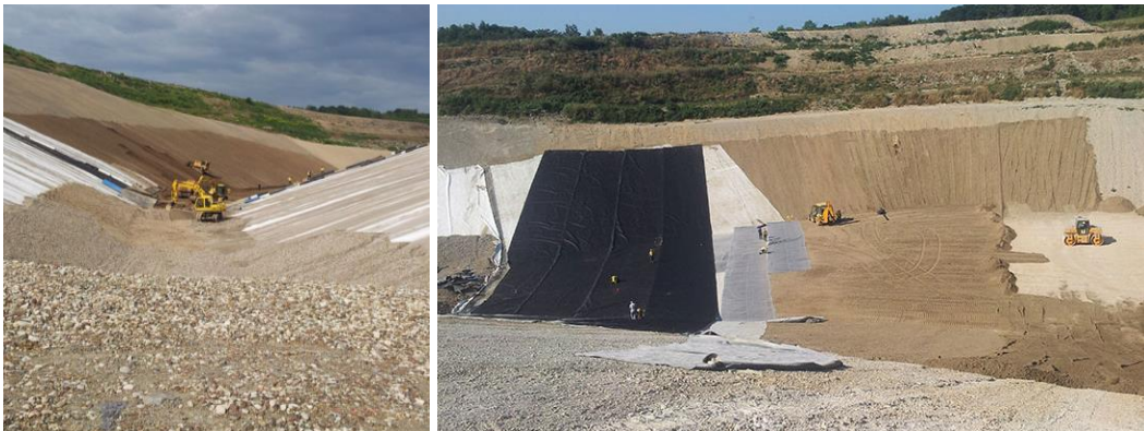
Slika 10.21. Ugradnja drenažnog materijala, bentonita i PEHD (HDPE) folije na deponiji Ramići (EKO-EURO TIM, 2014)
