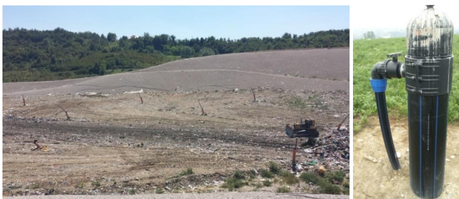
Slika 10.7. Savremeni sistem za sakupljanje deponijskog gasa na regionalnoj deponiji Ramići kod Banjaluke (slika desno – izgled bunara za sakupljanje deponijskog gasa)
