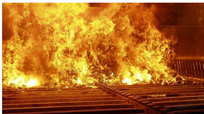
Slika 9.6. Peći spalionice sa pokretnom rešetkom kapaciteta 15 t 3 otpada na sat. Vidljive su rupe na rešetki koja obezbijuje primarni vazduh za sagorijevanje (Claush66, 2007)
