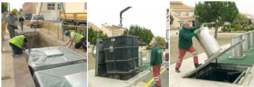
Slika 5.27. Podzemni kontejneri sa pražnjenjem sa dizalicom (LPUO grada Beograda, 2012)
