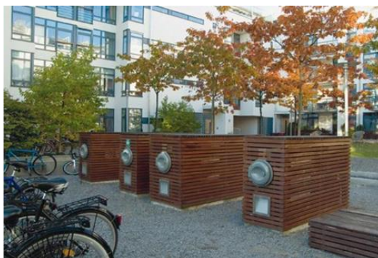
Slika 5.13. Sabirne tačke automatizovanog vakuum sistema integrisane u gradsko okruženje Štokholma (Envacgroup, 2012)
