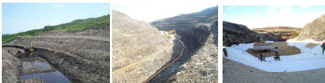
Slika 10.24. Djelimična sanacija starog dijela deponije Ramići kod Banjaluka: a) Prosjecanje kanjona kroz stari dio otpada. b) Postavljanje drenažne cijevi za prikupljanje i odvođenje atmosferskih voda. c) Postavljanje geomreže (DE–POT, 2010)
