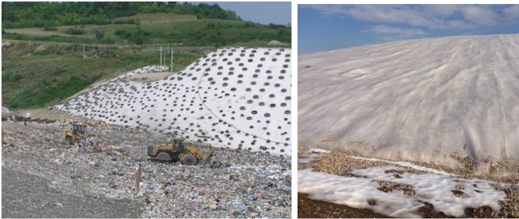
Slika 10.22. Geomreža na deponiji Ramići - povećava nosivost i pomaže da drenažni kamen ne sklizne sa kosine (DEPOT, 2016)
