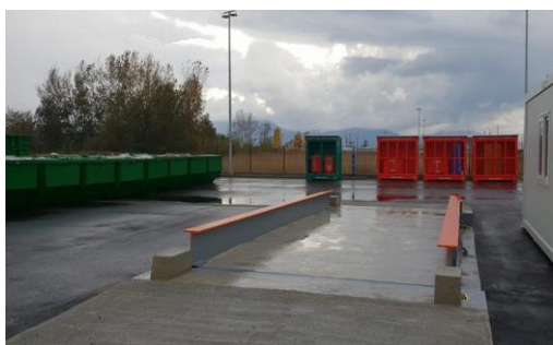
Slika 5.7. Vaga za mjerenje težine dopremljenog otpada u reciklažno dvorište
